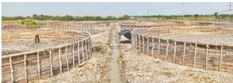
Proses pembuatan kolam bundar (foto Erick Widi, SpV TS STP Purwakarta)
